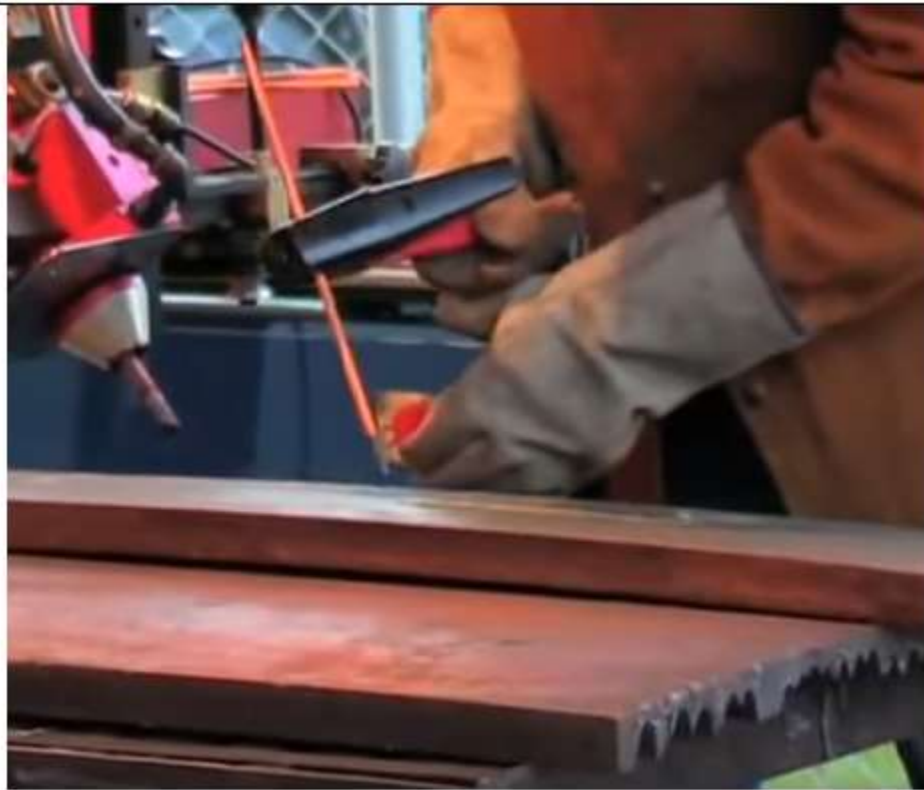
Elektrodu držati na rastojanju oko 120- 150 mm od predmeta
